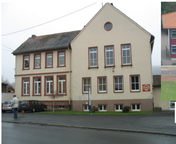
Altbau der KBS (Nordseite)
