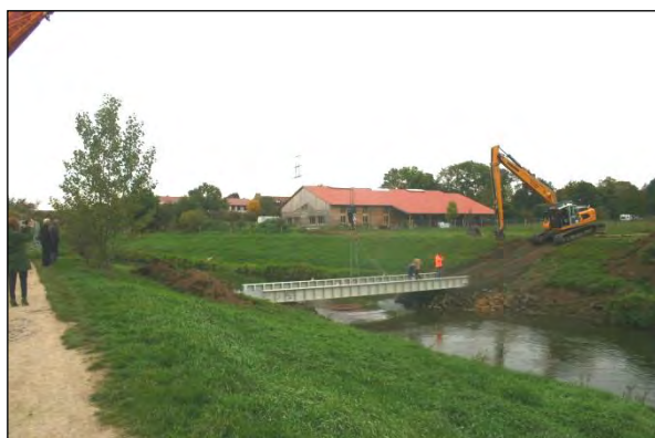
Links: Für die Baustelle wurde eigens eine mobile Brücke errichtet. Rechts: Die Doppelschleife ist fertig, jetzt muss es nur noch grün werden
