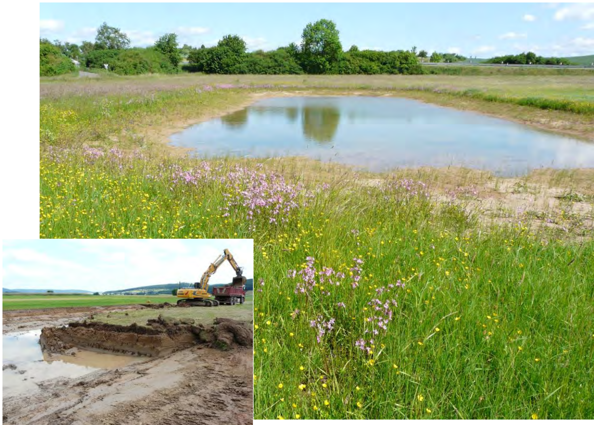
Fotos: Die Flutmulde beim Bau und im Frühsommer bei niedrigem Wasserstand
