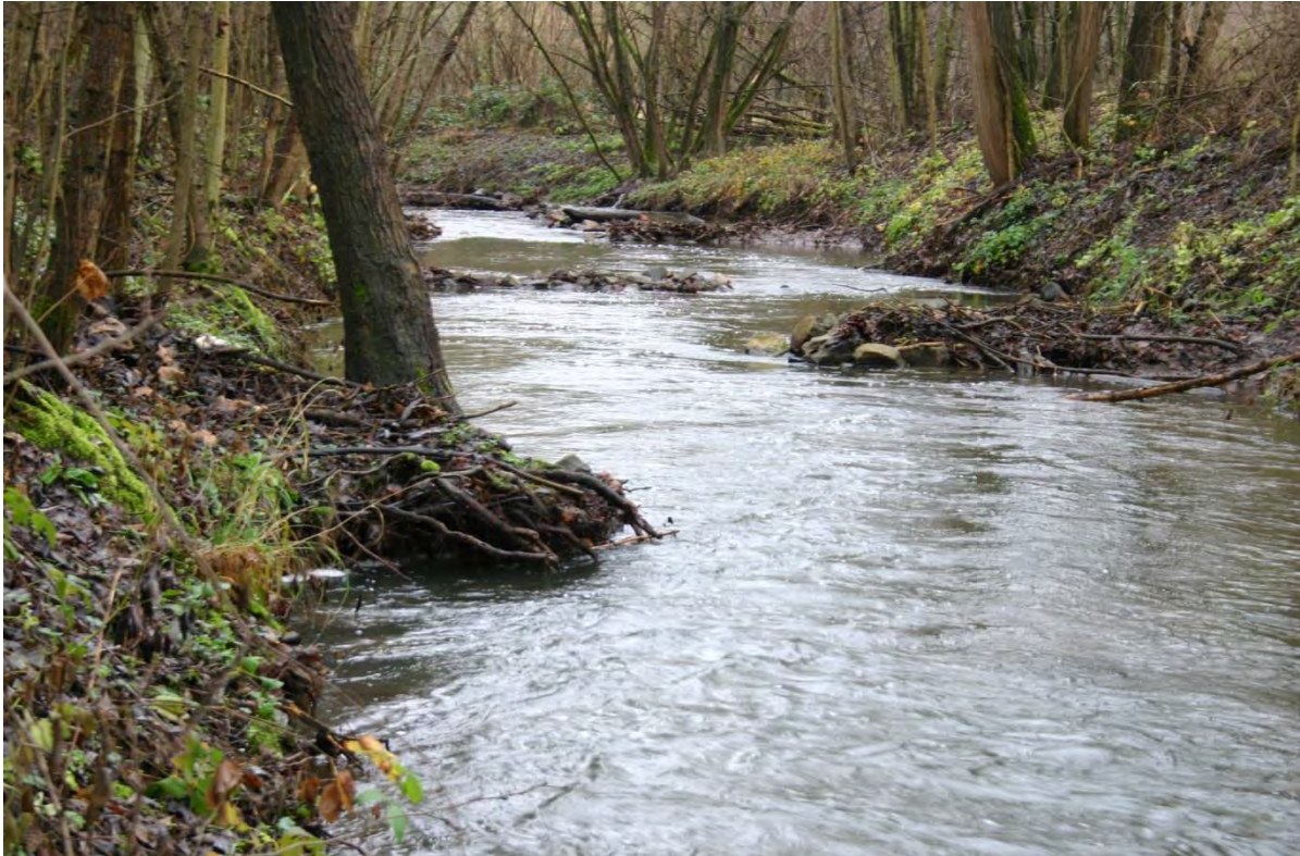
Foto (G. Lehr): Durch Buhnen wird die Mäandrierung eingeleitet. Die Baumwurzel links ist schon unterspült. In naher Zukunft beginnt der Erlenbach sich merklich zu verlagern.
