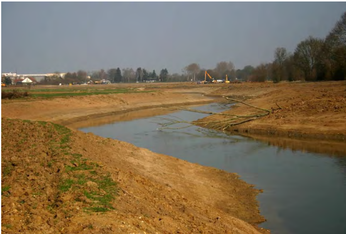
Foto: Die neue Niddaschleife ist direkt vom Uferweg einzusehen.
