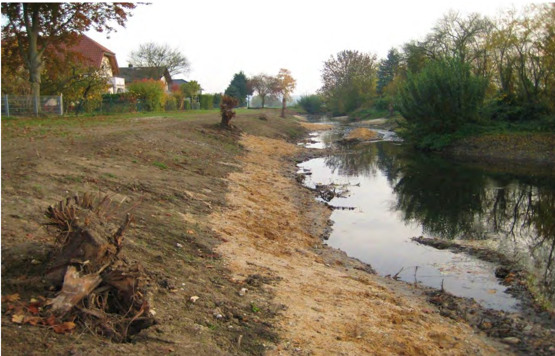
Foto: Nach Abschluss der Bauarbeiten Ende Oktober 2015
