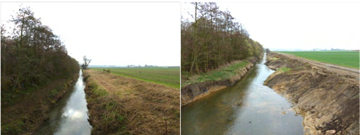
Fotos: Links die Horloff als strukturarmer geradliniger Kanal vor der Renaturierung, rechts noch unbegrünt unmittelbar nach Abschluss der Ufergestaltungsmaßnahmen
