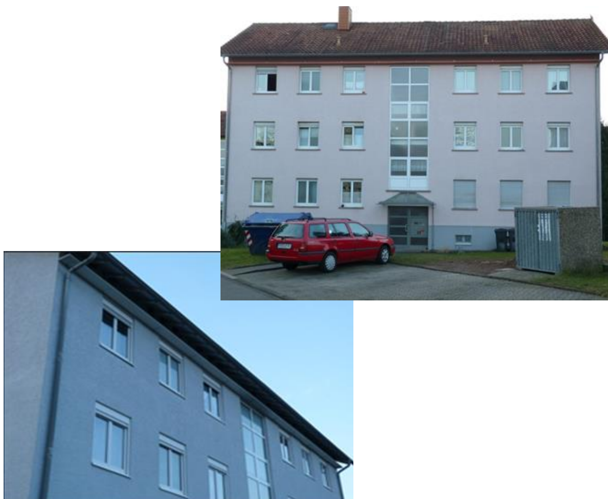
Fotos: Durchgehende Kotbretter in der Farbe des jeweiligen Gebäudes in Büdingen (Fotos von A. Leiß)
