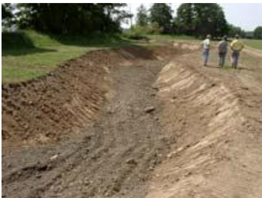
Bild 2+3: In den neu angelegten Seitenarmen wurden Geschiebedepots angelegt. Das bedeutet, dass hier für die Renaturierung ca. 2100 t Flusskies auf die Sohle der Seitenarme verteilt wurde. Hierdurch entstehen natürliche Fließstrecken, die in der Nidda nur noch selten vorhanden sind.
