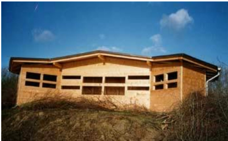
Bild: Der neu errichtete Beobachtungsstand im NSG „Mittlere Horloffau“ nahe der Ortslage von Utphe
