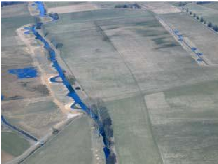
Bild 1: Luftbildaufnahme März 2003. Zu sehen ist der mittlere Bereich der Renaturierungsmaßnahme. Links unten mündet der Heeggraben in den Schwaasgraben sowie eine neu angelegte Flutmulde.
