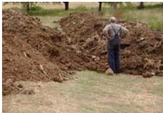
Bilder: Grabenräumung und Zwischenlagerung des Aushubs auf Mieten
