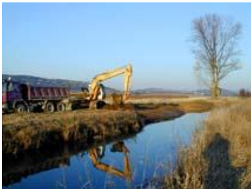
Bild 4+5: Baggerarbeiten: Abflachen der Ufer und Aufweitung des Gewässerprofils. Die Erdmassen wurden auf LKWs geladen und außerhalb der Aue auf Ackerflächen verteilt. Hierdurch wurde vermieden, dass hochwertiger Böden für viel Geld auf Deponien gefahren wird. Durch das gute Bodenmanagement konnten beachtliche Kosten für das Gesamtprojekt eingespart werden.
