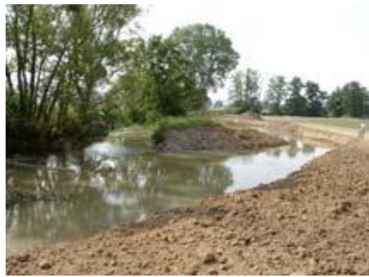
Bild 2+3: In den neu angelegten Seitenarmen wurden Geschiebedepots angelegt. Das bedeutet, dass hier für die Renaturierung ca. 2100 t Flusskies auf die Sohle der Seitenarme verteilt wurde. Hierdurch entstehen natürliche Fließstrecken, die in der Nidda nur noch selten vorhanden sind.
