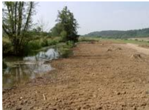
Bild 4+5: Baggerarbeiten: Abflachen der Ufer und Aufweitung des Gewässerprofils. Die Erdmassen wurden auf LKWs geladen und außerhalb der Aue auf Ackerflächen verteilt. Hierdurch wurde vermieden, dass hochwertiger Böden für viel Geld auf Deponien gefahren wird. Durch das gute Bodenmanagement konnten beachtliche Kosten für das Gesamtprojekt eingespart werden.
