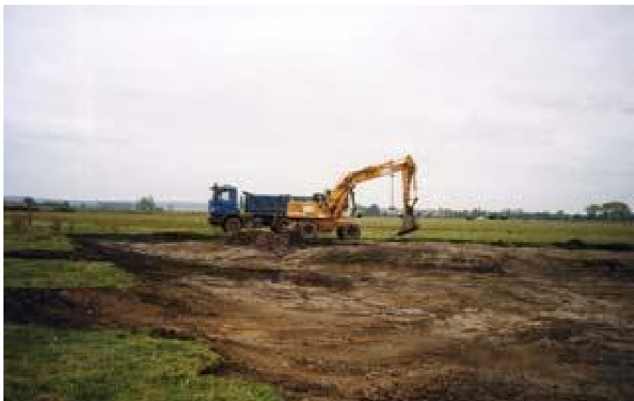
Bild: Fa. Heck bei der Anlage des Flachwasserteiches im „Bingenheimer Ried“
