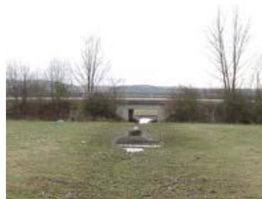
Bild: Eine neue Flutrinne als Durchlass unter der Umgehungsstraße
