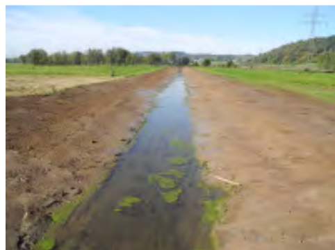
Fotos rechts: Der Graben vor und nach der Umsetzung der Böschungsgestaltung
