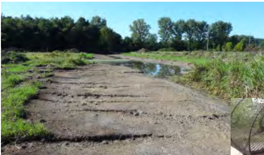
Flach ausgezogene Uferböschungen
