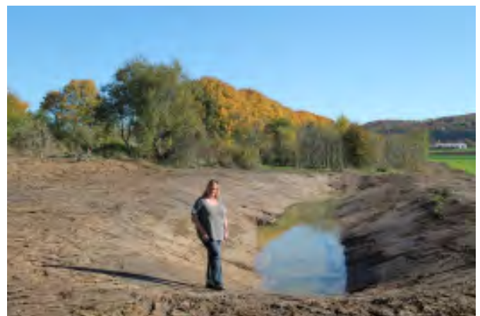
Christiane Meub nach dem Aushub
