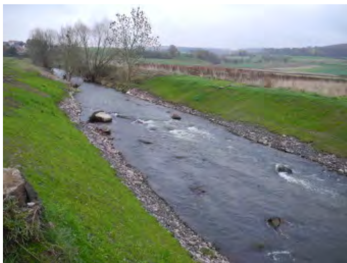
Foto: Im linken Bild erkennt man den massiv verbauten Sohlabsturz mit der anschließenden Aufweitung, im rechten Bild die neu erstellte „Rauhe Rampe“ mit der Fußsicherung und den Störsteinen
