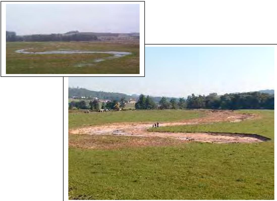
*Bild 2 u. 3: Der ehemalige Verlauf der Nidder, der bei hohem Wasserstand im Gelände noch schwach erkennbar war (links oben), wurde in Form einer periodisch wasserführenden Flutrinne mit größeren Ausbuchtungen wiederhergestellt.*
