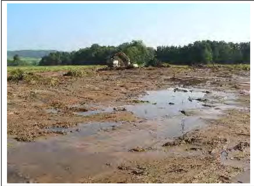
*Bild 3 u. 4: Im zentralen Bereich des Projektgebietes wurde ein großer Flachwasserteich mit mehreren Inseln angelegt. Das obere Bild zeigt den Teich während der Bauarbeiten, das untere nach Abschluss der Maßnahme. Durch Beweidung mit Rindern und Pferden sollen die Ufer in Zukunft frei von Gehölzen und Hochstauden gehalten werden.*
