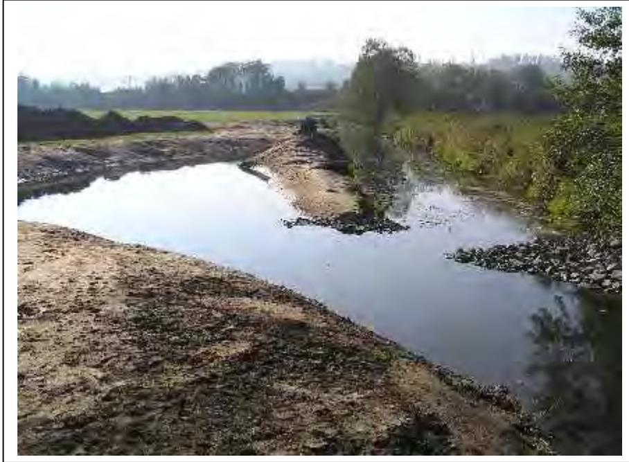
*Bild 1: Neuprofilierung des Flussbetts unterhalb der Nidderbrücke. Rechts der alte geradlinige Flusslauf. Durch das Leitwerk aus Basaltsteinen wird die Strömung in die neu angelegte Flussschlinge nach links gelenkt.*
