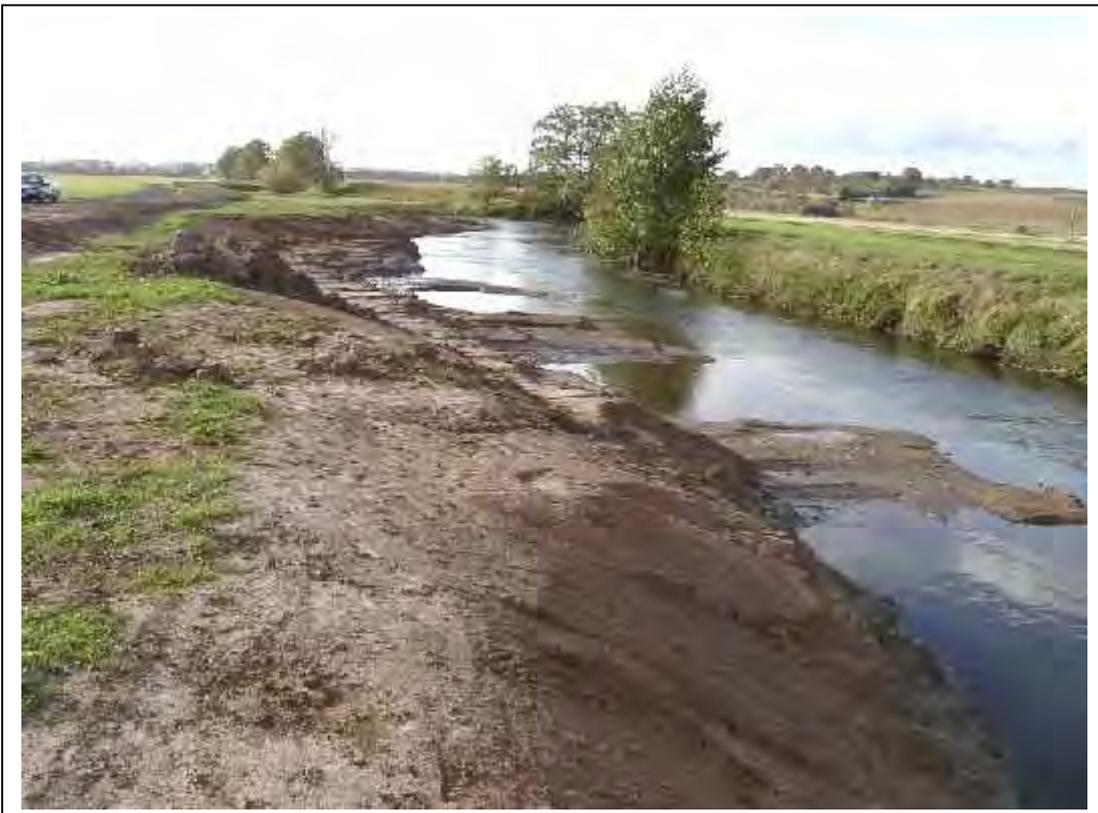
*Bild 2: Aufweitungen des Flussbettes auf der linken Bildseite, rechts altes Ufer*
