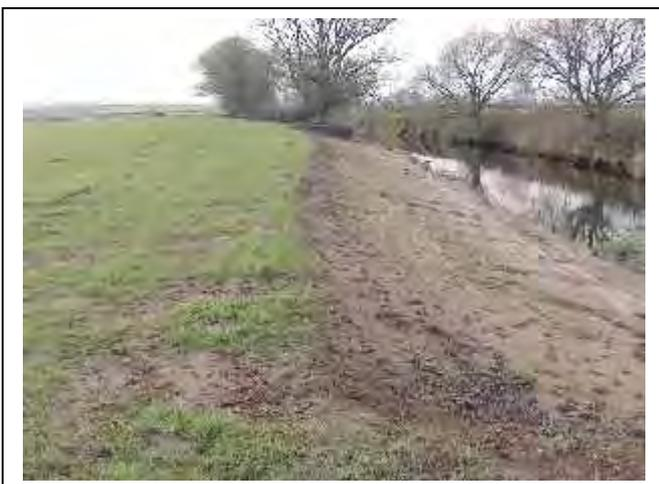
*Bild 5: Uferabflachung an der Nidda*
