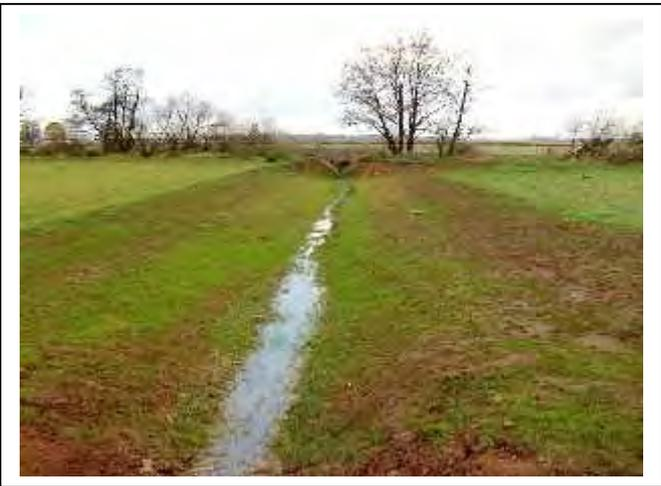
*Bild 4: Graben mit Uferabflachung nachher*
