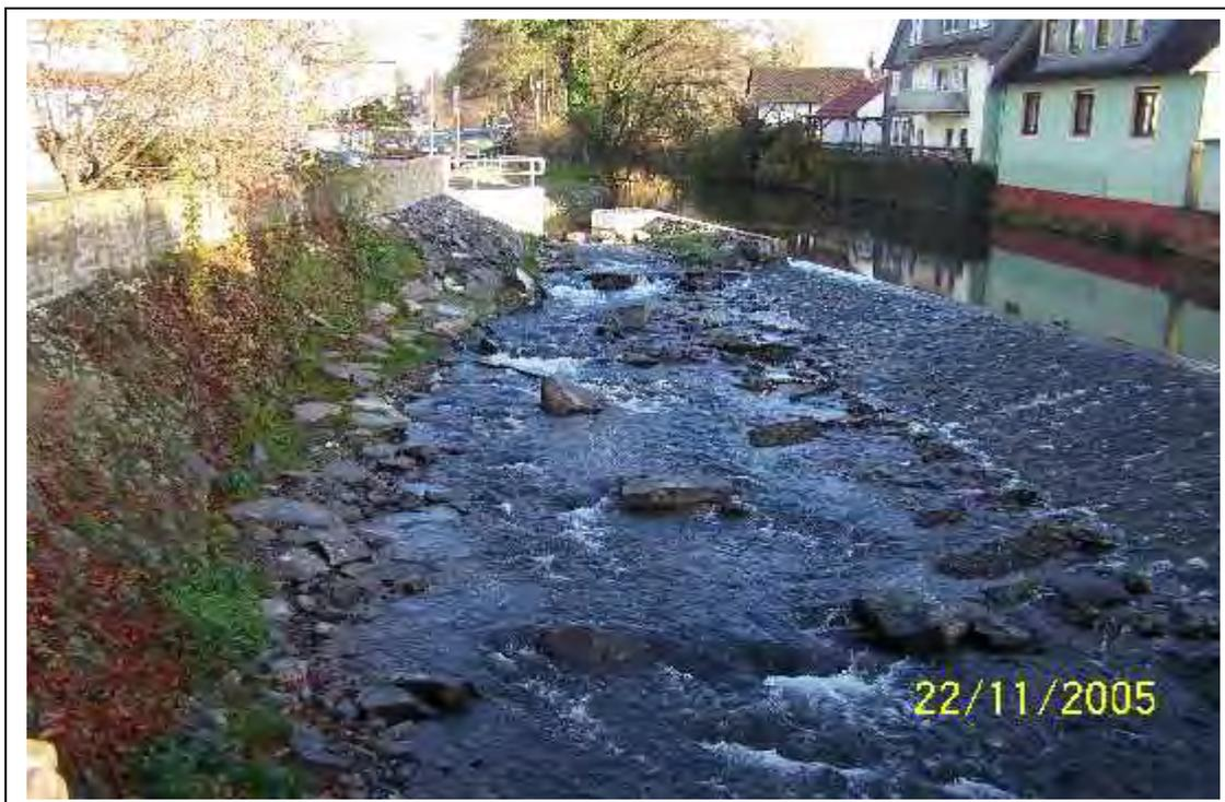
*Bild: Blick von der Stadtmühlenbrücke ins Oberwasser: In der Mitte die neu angelegte Rampe, rechts das alte vorhandene Streichwehr*
